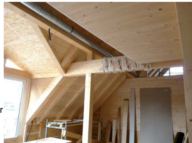
Abb 4. Innenansicht auf das zukünftige Büro vom Architekten. Gut sichtbar das Lüftungssystem an der Decke sowie die filigran gestalteten Sparren mit zusätzlicher Dämmebene. (Quelle: GUTEX)
